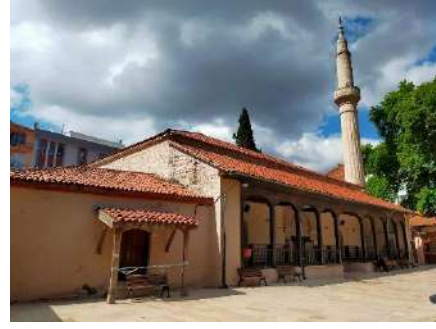
Şekil 2. Kuzey cephesinden genel görünüm
