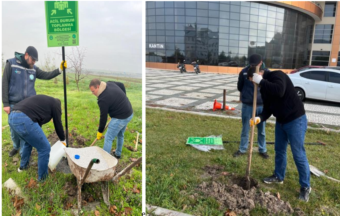
Şekil III.16: Acil toplanma alanlarının belirlenmesi ve levha asılması.
