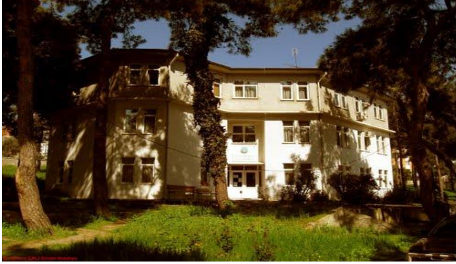
Güzel Sanatlar Eğitimi Bölüm Binası (C Blok)
