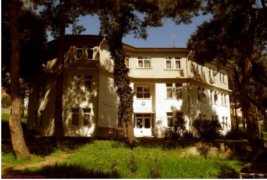
Güzel Sanatlar Eğitimi Bölümü Binası (C Blok)
