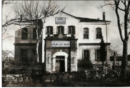
1924-1926 Balıkesir İmam ve Hatip Mektebi Binası 9
