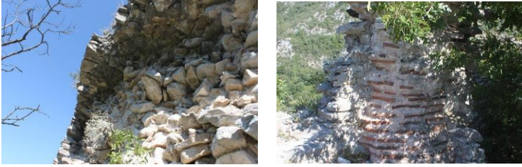
Resim 6-7. Keçiağlı Kalesi duvarlarında taş ve tuğla işçiliği.
