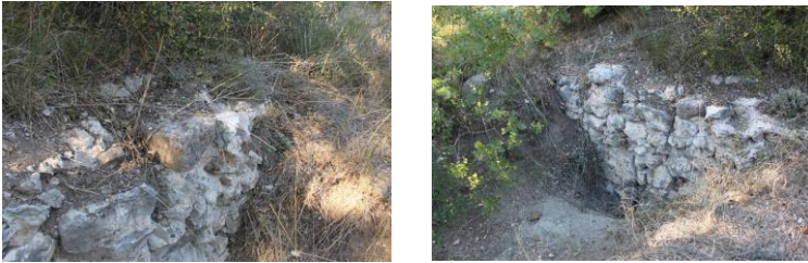
Resim 8-9. Dereköy Kalesi’nde kaçak kazılar sonrası açığa çıkan duvarlar.
