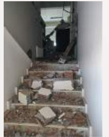
Şekil 3.50. Asma tavan ve bölme duvar hasarları
