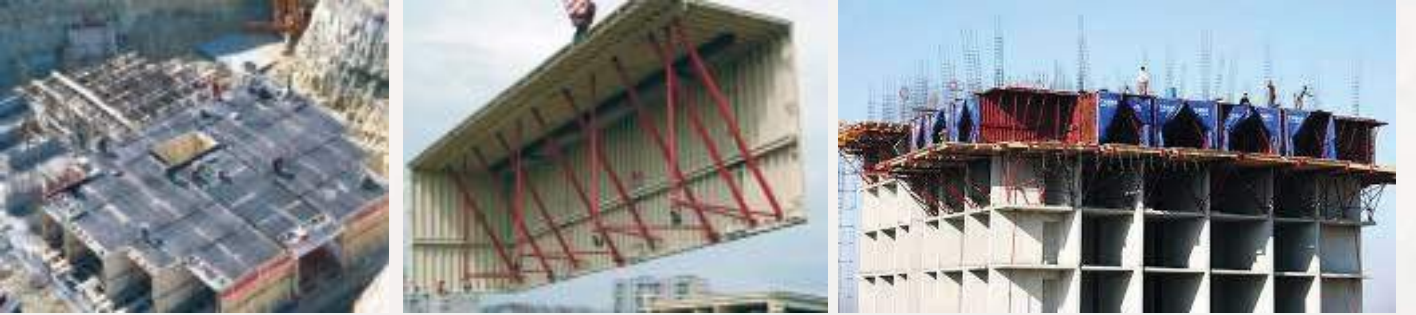
Şekil 4.3. Tünel kalıp sistem ile bina inşaatı
