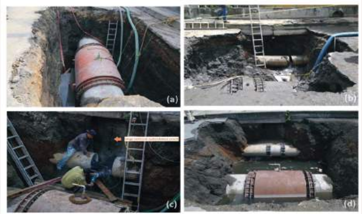
Şekil 5.2.5. Mexico City’deki Colonia Del Mar bölgesinde yaygın olarak görülen boru hattı hasarları ve onarımı (Lemnitzer ve diğ., 2021)
