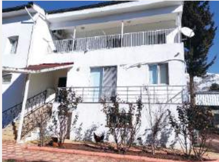
Şekil 4.60. Kaymakamlık Lojmanı binasının genel görünüşü
