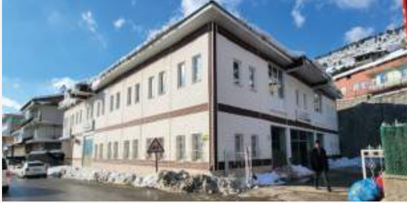
Şekil 3.65. Çelikhan İlçesi ASM binası
