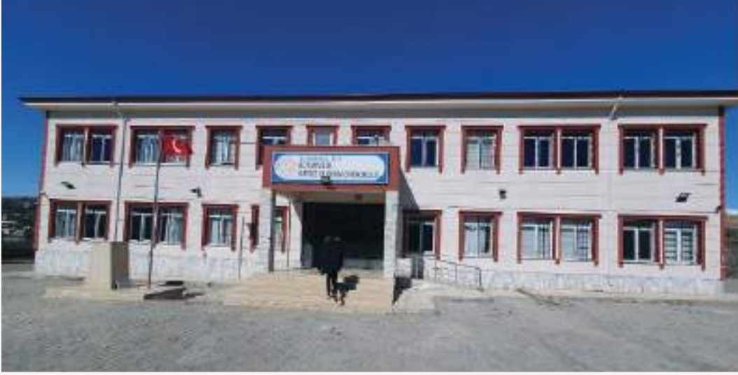
Şekil 3.67. Boyundere Hatice Yıldırım Ortaokul binası
