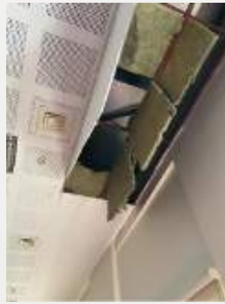
Şekil 3.50. Asma tavan ve bölme duvar hasarları
