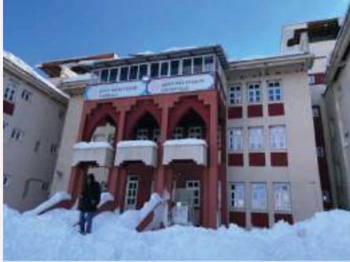
Şekil 3.25. Şehit Mesut Çelik İlkokulu ve Ortaokulu
