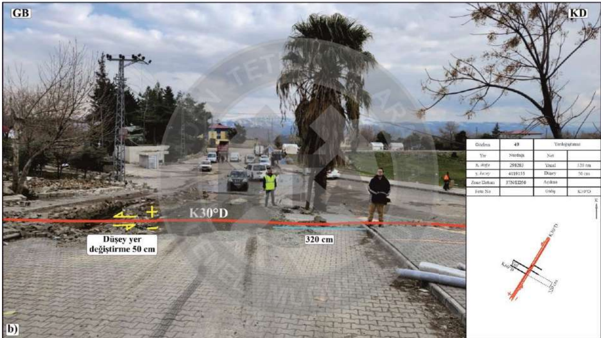
Şekil 4. 22. 06 Şubat 2023 Pazarcık (Kahramanmaraş) Depremi (Mw 7,7) sırasında Nurdağı ilçe merkezinin kuzeybatısındaki Beşpınar köyünün içindeki parke taşlı yolu kesen yüzey kırığına ait fotoğraf a) Yorumlanmamış b) Yorumlanmış.
