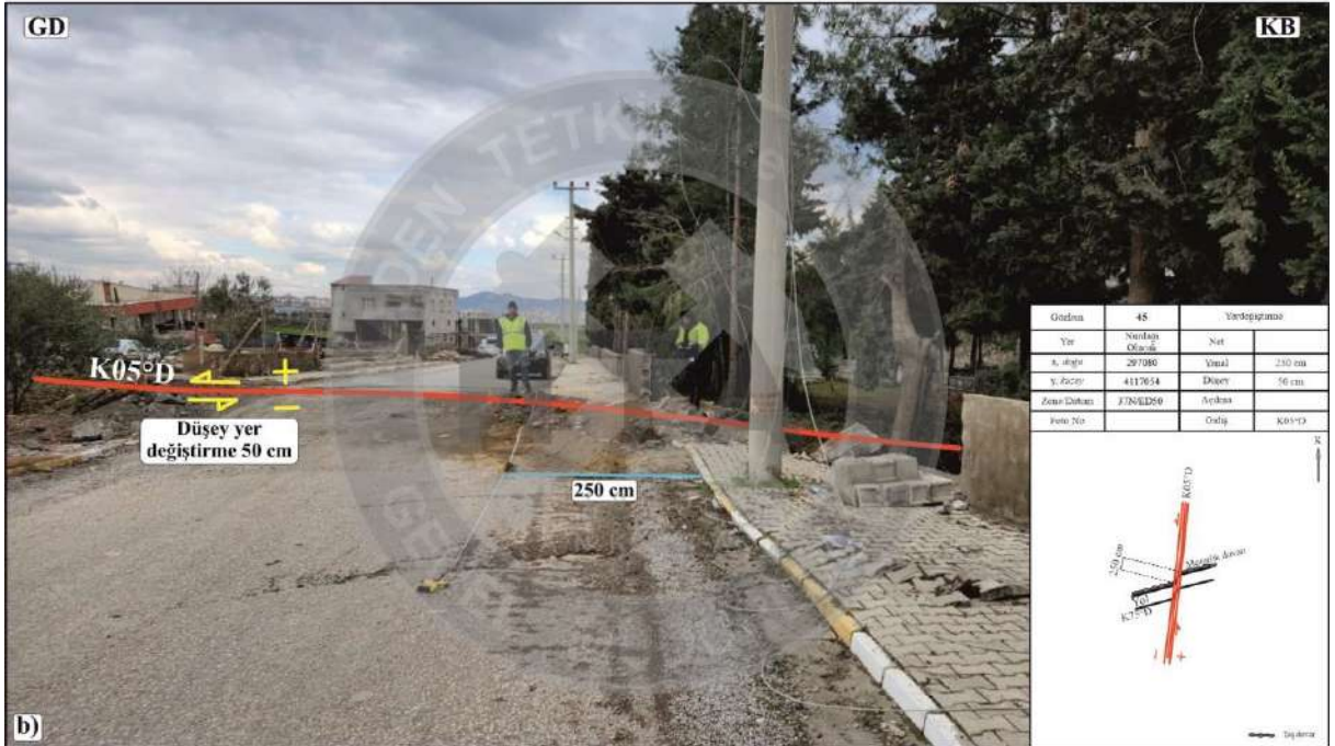
Şekil 4. 20. 06 Şubat 2023 Pazarcık (Kahramanmaraş) Depremi (Mw 7,7) sırasında Nurdağı ilçe merkezinin güneybatısındaki Aşağıolucak mahallesindeki mezarlık duvarını ve yolu kesen yüzey kırığına ait fotoğraf a) Yorumlanmamış b) Yorumlanmış.
