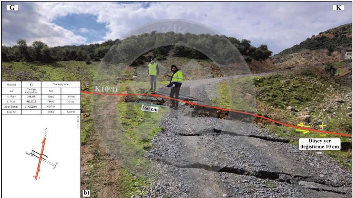
Şekil 4. 19. 06 Şubat 2023 Pazarcık (Kahramanmaraş) Depremi (Mw 7,7) sırasında Nurdağı ilçe merkezinin güneybatısındaki stabilize yolu kesen yüzey kırığına ait fotoğraf a) Yorumlanmamış b) Yorumlanmış
