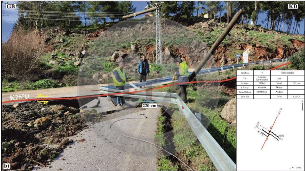
Şekil 4. 4. 06 Şubat 2023 Pazarcık (Kahramanmaraş) Depremi (Mw 7,7) sırasında Ceylanlı köy yolunu ve bariyerleri kesen yüzey kırığına ait fotoğraf a) Yorumlanmamış b) Yorumlanmış.
