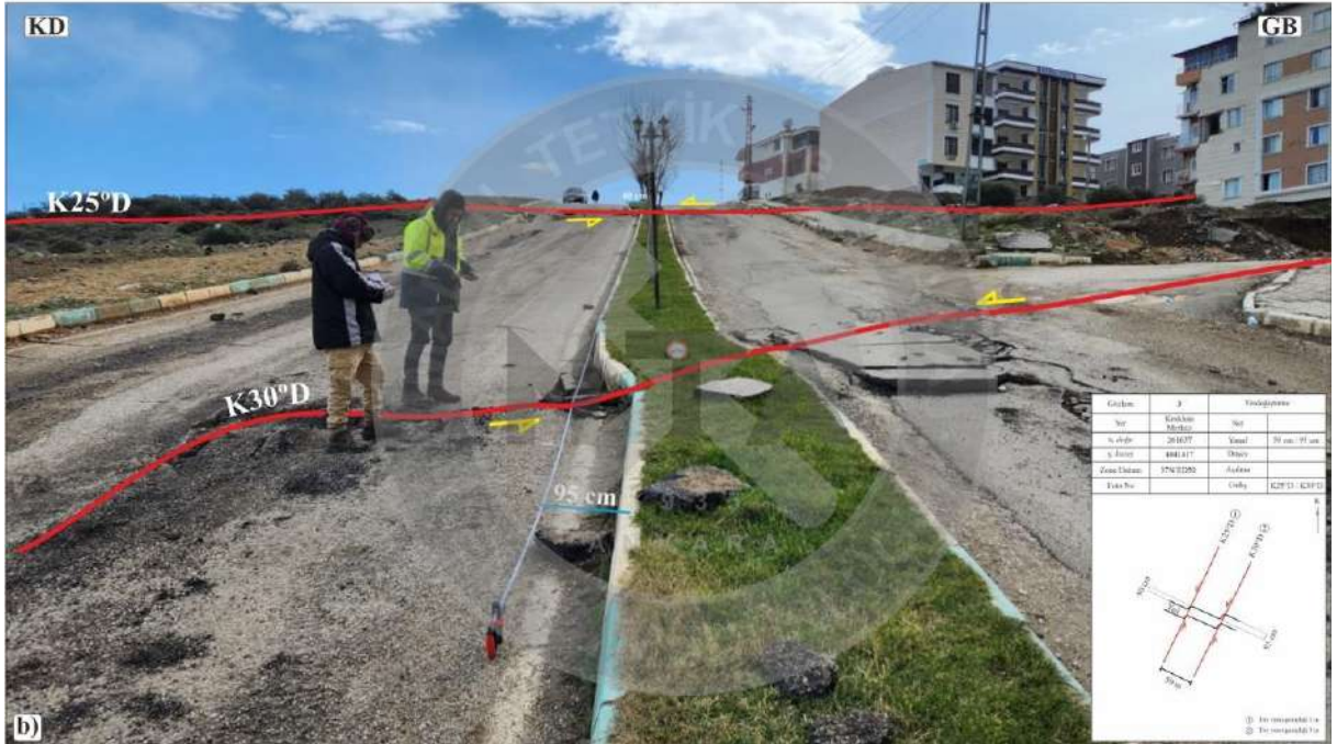
Şekil 4. 2. 06 Şubat 2023 Pazarcık (Kahramanmaraş) Depremi (Mw 7,7) sırasında Kırıkhan ilçe merkezinde gelişen yüzey kırığına ait fotoğraf a) Yorumlanmamış b) Yorumlanmış.
