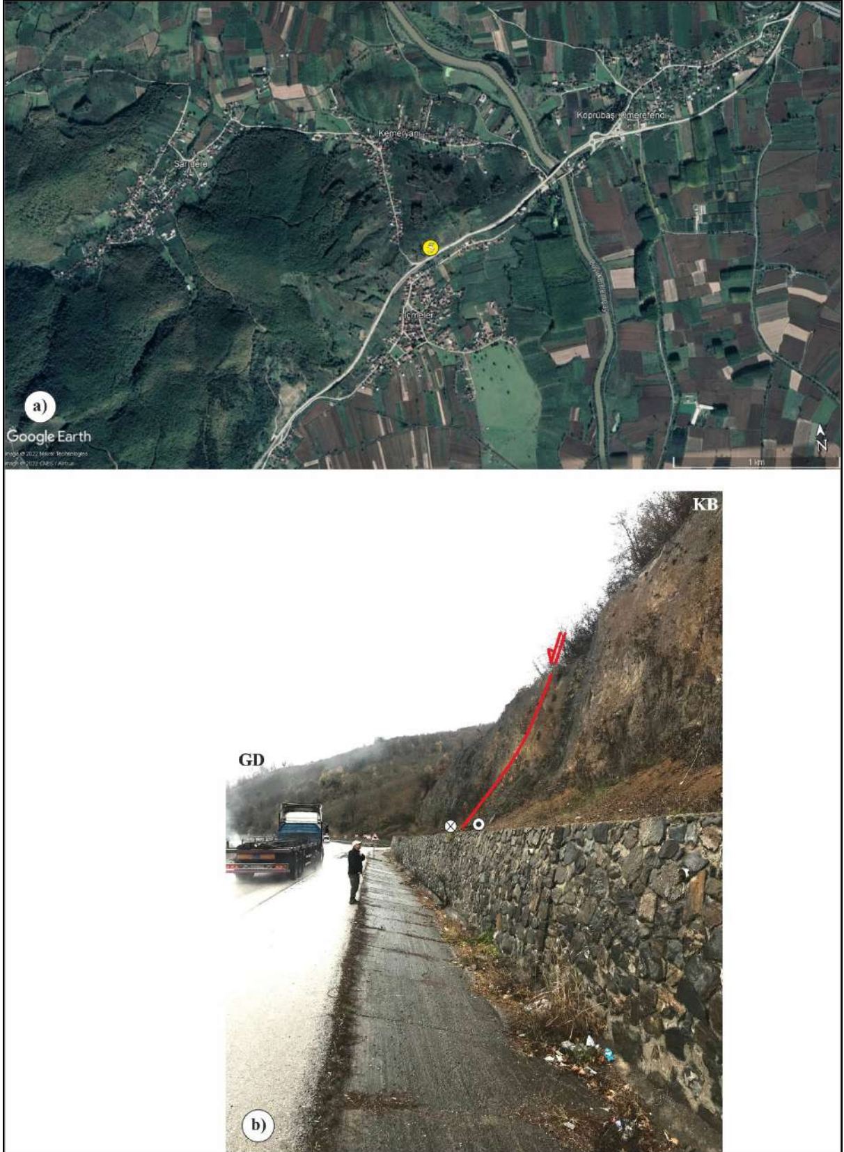
Şekil 4.10. Düzce – Gölyaka karayolunun İcmeler Köyü mevkiinde Eosen yaşlı volkanitleri kesen Karadere Segmenti'nin Google Earth uydu görüntüsü üzerindeki yer buldurusu (a) ve arazi görüntüsü (b) (Bakış Güneybatı'ya doğrudur).
