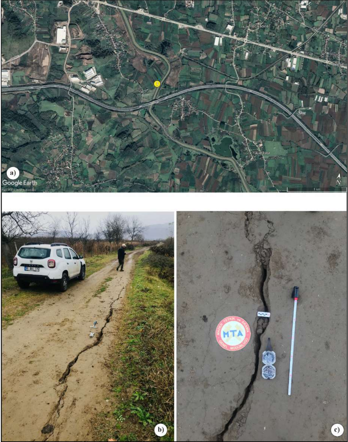
Şekil 4.8. Yakabaşı Köyü'nün 1,10 km güneydoğusunda, Büyük Melen Çayı'nın batı sahili boyunca, stabilize yol üzerinde yanal yayılmaya bağlı olarak gelişen, K08°D doğrultulu kılcal çatlakların Google Earth uydu görüntüsü üzerindeki yer buldurusu (a), uzak alan (b) ve yakın plan (c) görünümü (Bakış Kuzey'e doğrudur).
