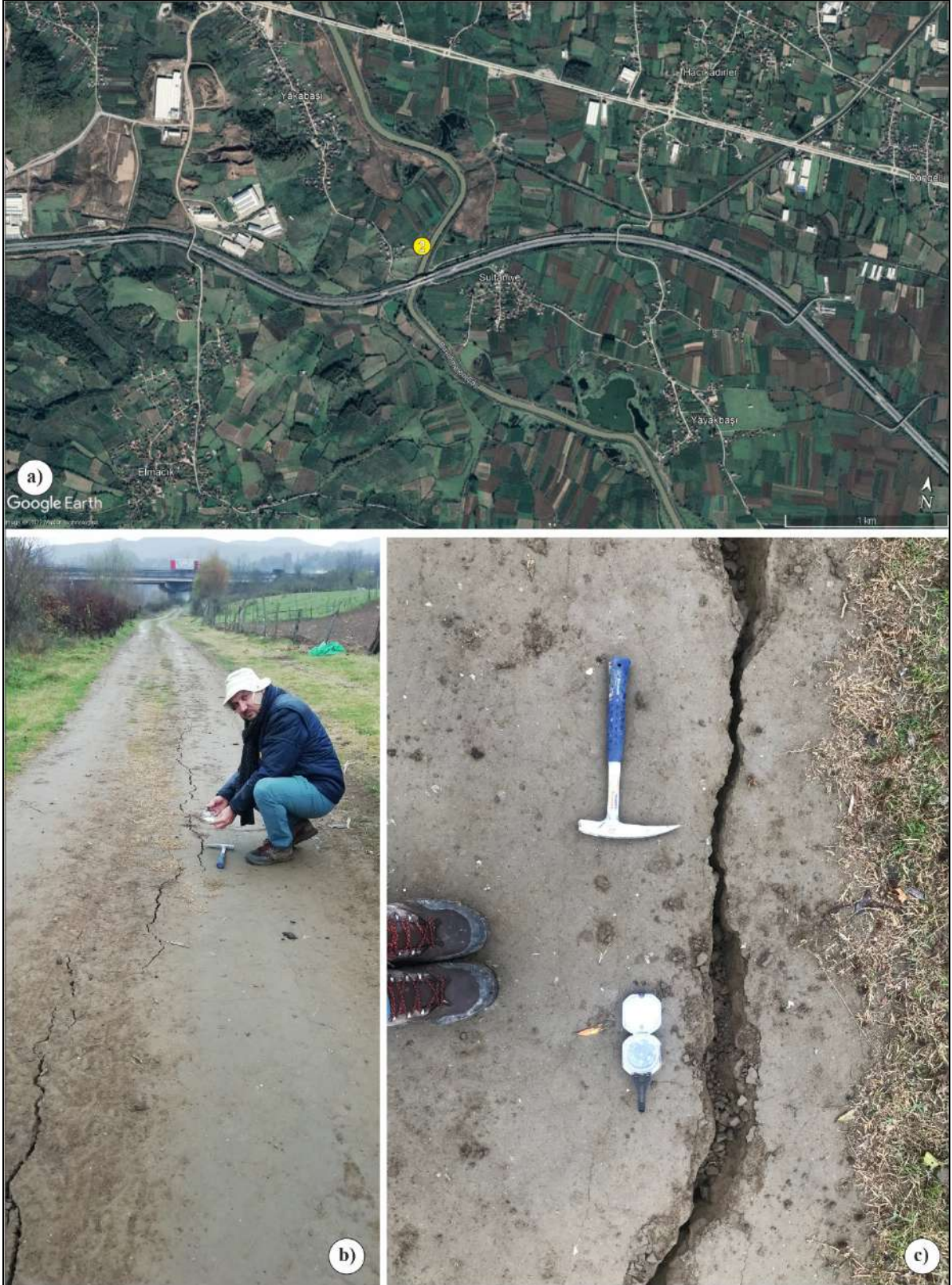
Şekil 4.7. Yakabaşı Köyü'nün 1,16 km güneydoğusunda, Büyük Melen Çayı'nın batı sahili boyunca, stabilize yol üzerinde yanal yayılmaya bağlı olarak gelişen, K10°D doğrultulu kılcal çatlakların Google Earth uydu görüntüsü üzerindeki yer buldurusu (a), uzak alan (b) ve yakın plan (c) görünümü (Bakış Güney'e doğrudur).
