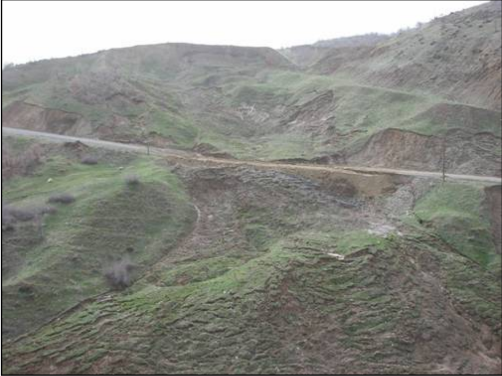
Şekil 18. Suvaran ile Bahçeli köyleri arasındaki yolda hasar neden olan yeniden aktivite kanmış heyelan (bakış batıya).
