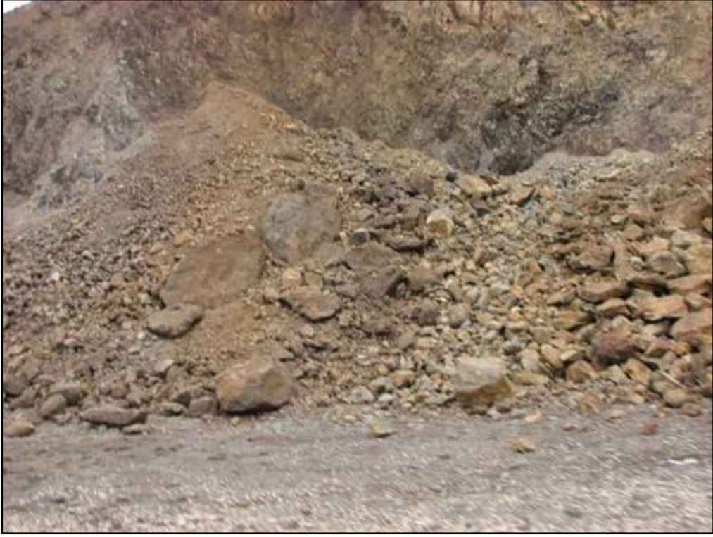
Şekil 21. Köklüce yolu yamaçlarında deprem sırasında meydana gelen moloz ve kaya düşmeleri.
