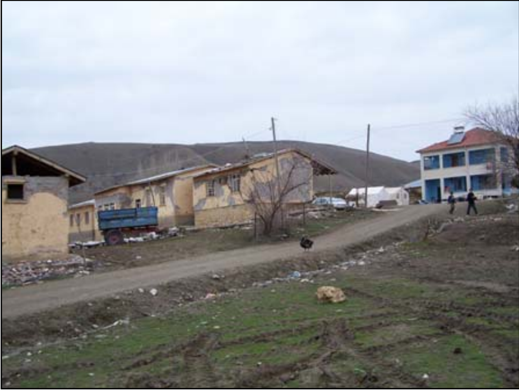
Şekil 23. Aşağı Kanatlı köyünde yığma yapılarda deprem sırasında meydana gelen hasarlar.
