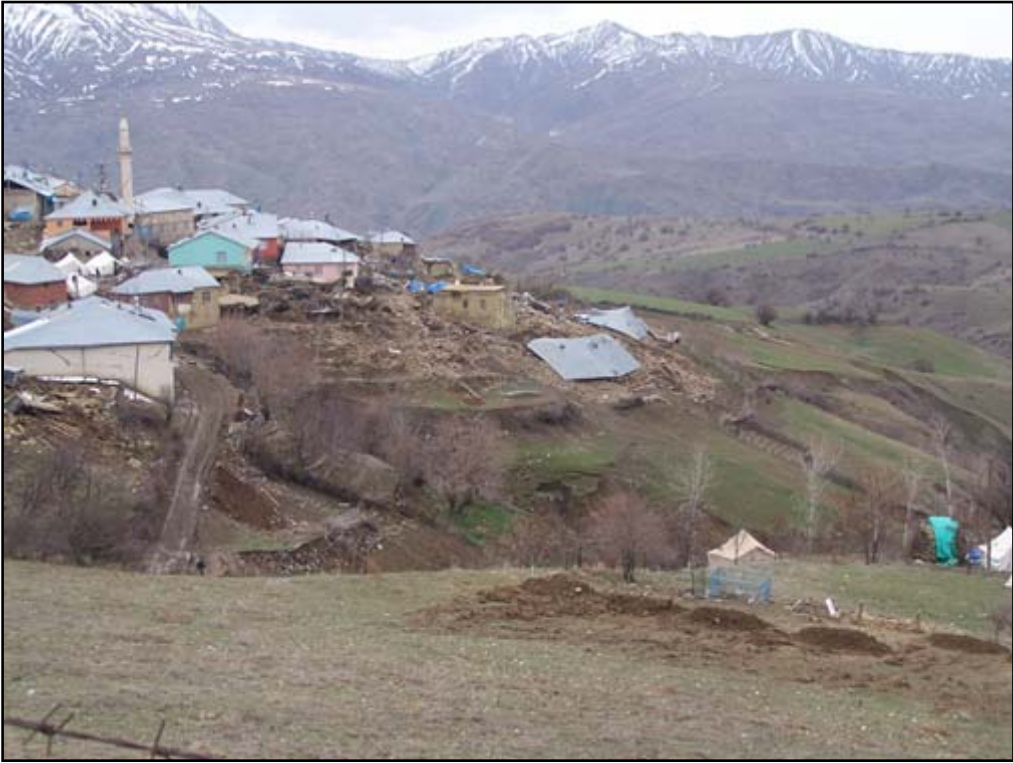
Şekil 24. Okçular köyünde deprem sırasında yamaç etkisi ve heyelan nedeniyle meydana gelen hasarlar.
