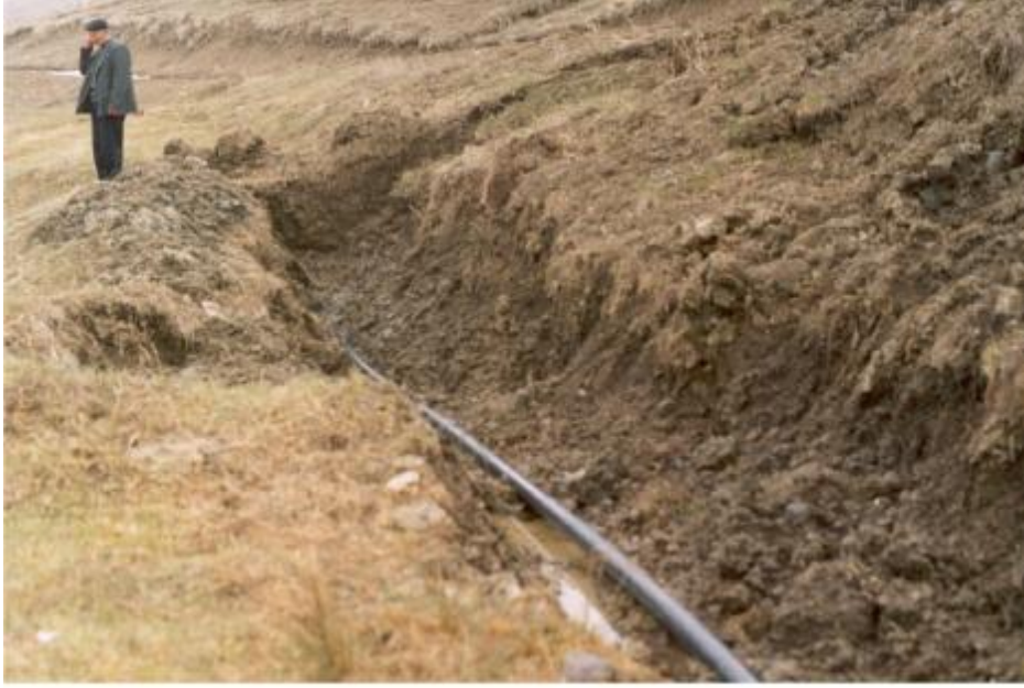
Foto 8: Alaca Köyü içme suyu şebekesinde sığ kaymalardan dolayı gelişen hasar. Bakış güneydir.
