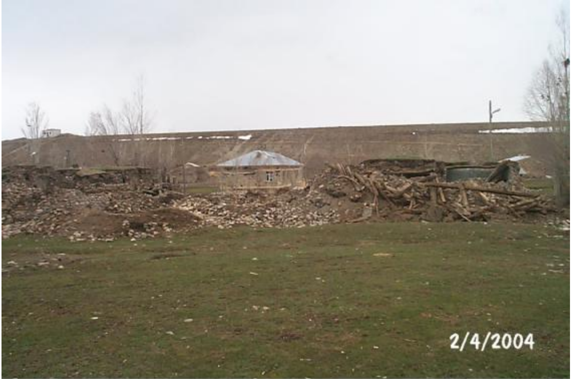
Foto 24: Tazegöl Köyünde geleneksel yığma yapılarda depremde meydana gelen hasar.
