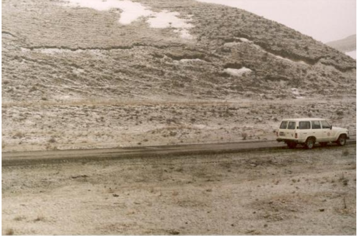
Foto 13: Alaca-Kandilli yolu üzerinde görülen sığ düzlemsel kaymalar. Bakış güncybatıyadır.
