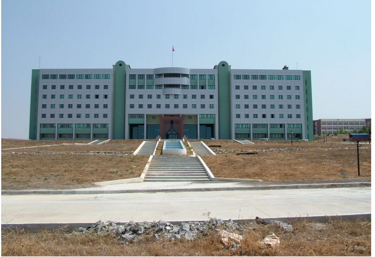
Tamamlanan Rektörlük Binası
