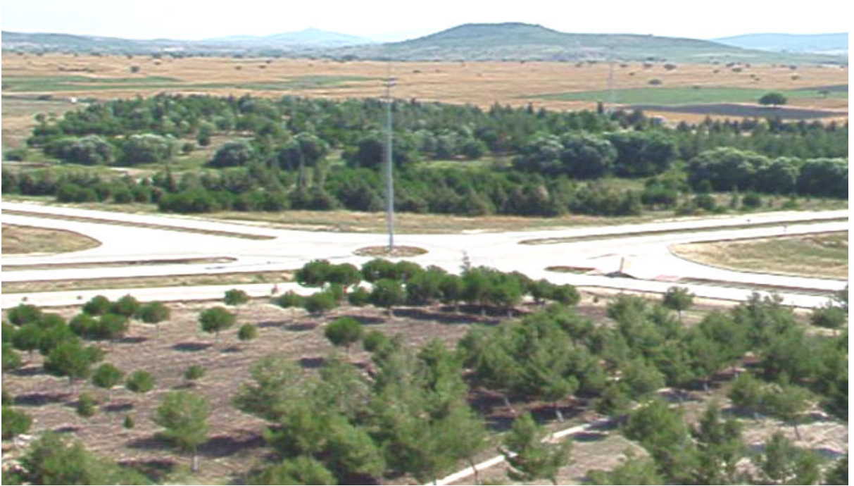
Kampüs Alt Yapı İnşaatı
