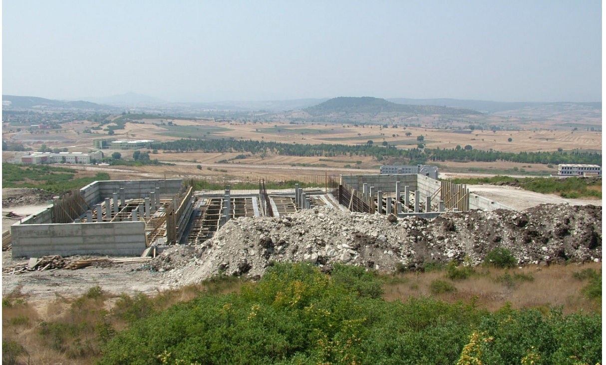
Su Deposu İnşaatı
