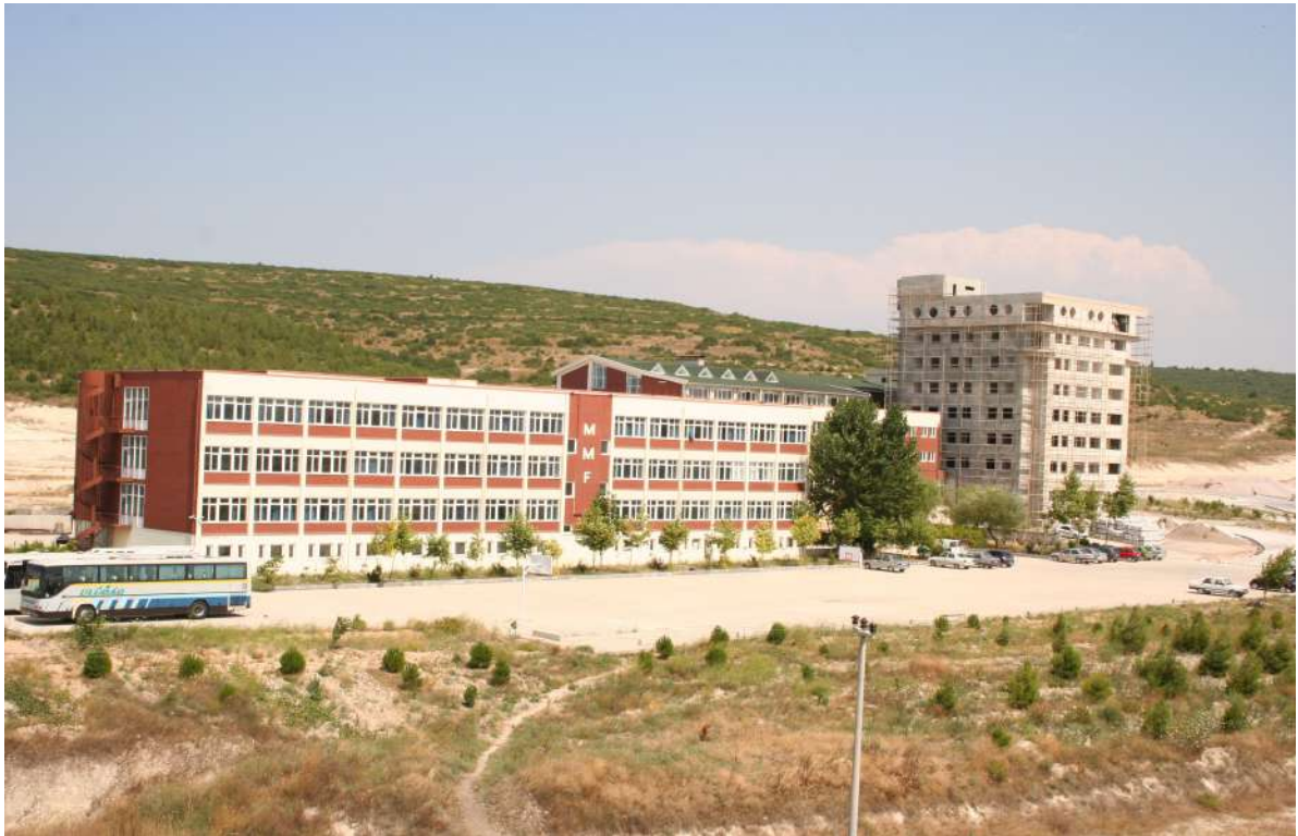
Mühendislik - Mimarlık Fakültesi İnşaatı
