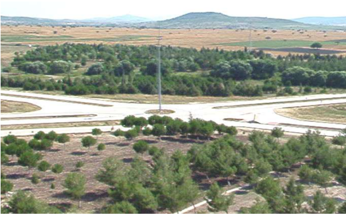
Kampus Alt Yapı İnşaatı
